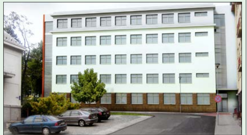
Křídlo D 1 monobloku D
